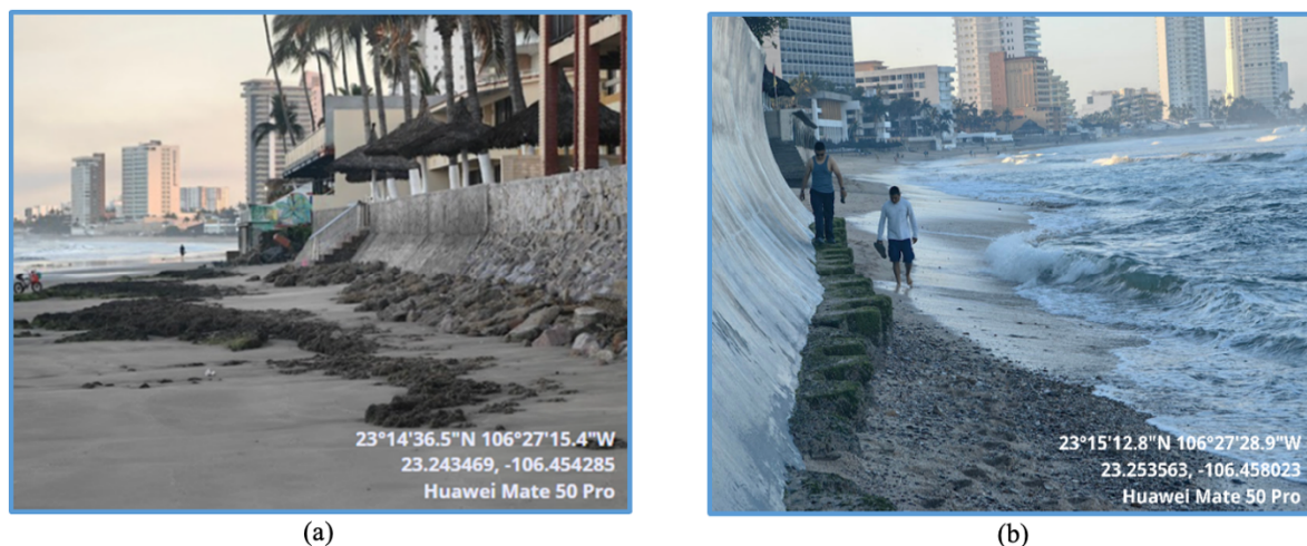
Figura 4. Evidencia de campo en el litoral urbano de Mazatlán: (a) socavación en estructuras rígidas, pérdida de berma y (b) reducción del ancho de playa frente a edificaciones.
