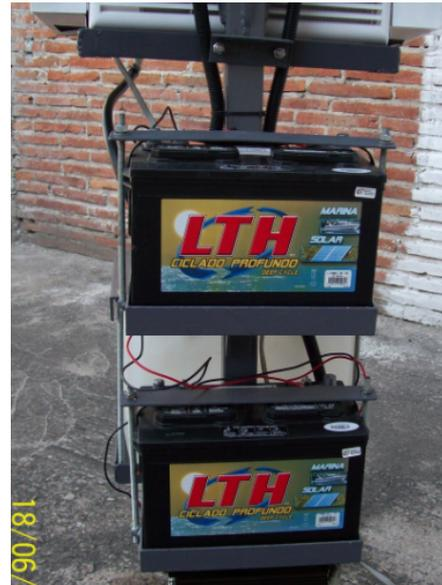
Figura 8 Baterías conectadas en paralelo.
