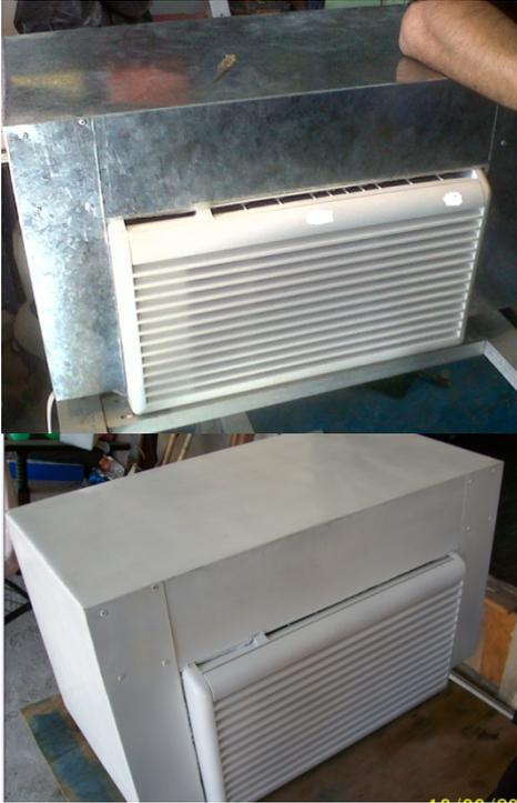
**Figura 4** Chasis para la recirculación de aire en el aparato acondicionador.
